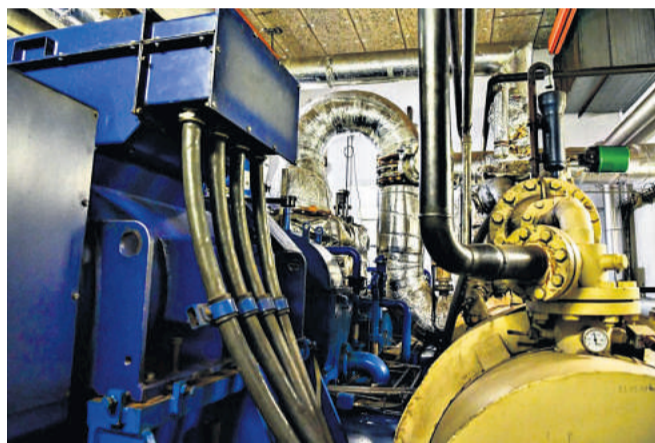
I dampturbinen hos Hjordkær Fjernvarme presses damp ind, og skovhjul i turbinen er forbundet til en generator, som producerer grøn strøm. Foto: Timo Battefeld
